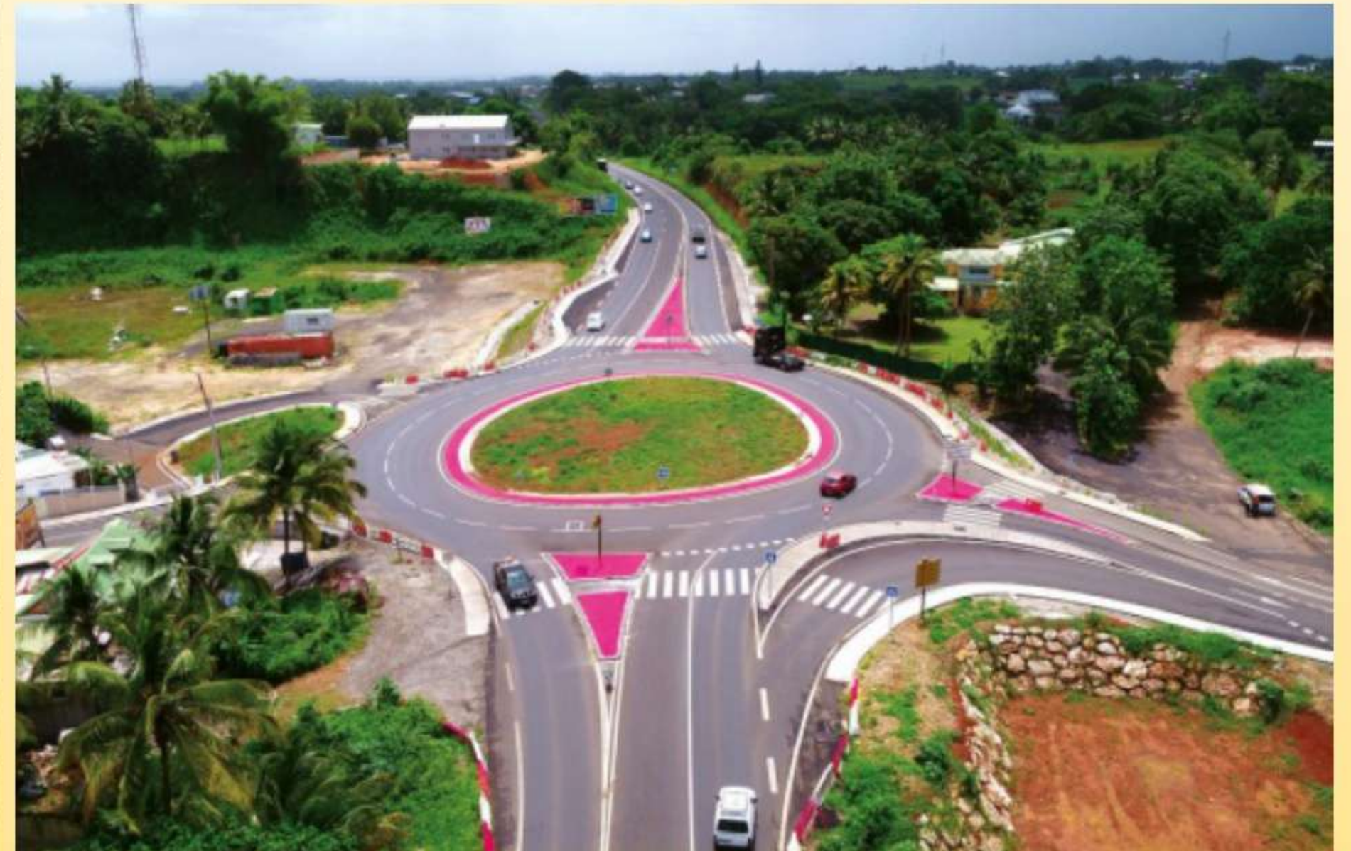
Carrefour Giratoire de Borel, RN2, Le Lamentin
